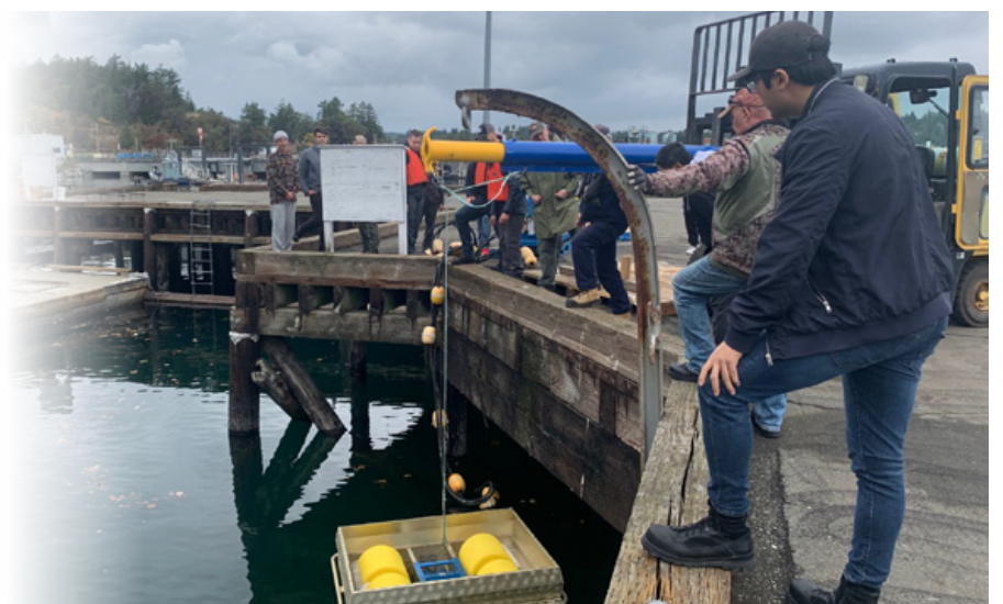
Une écumoire oléophile est placée dans l'eau alors que les participants s'engagent dans un scénario de déversement d'hydrocarbures pendant le cours de lutte contre les déversements d'hydrocarbures en mer.
